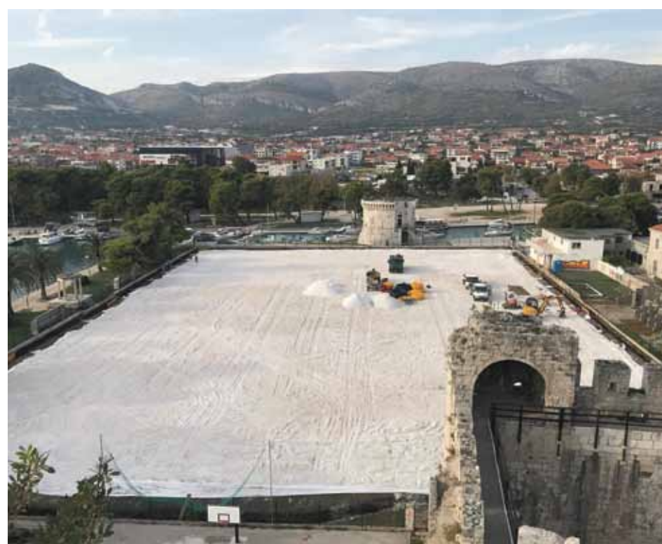
Lo stadio di Traù (Trogir) durante i recenti lavori di ristrutturazione
